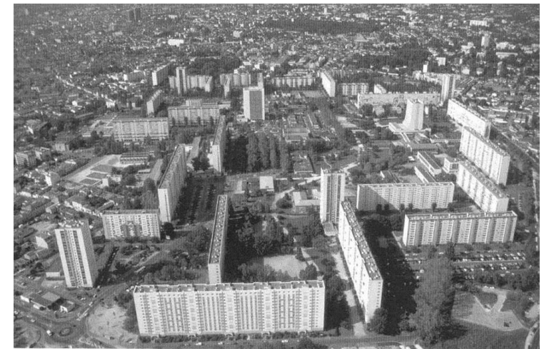
Quartier du Grand Parc, Bordeaux, France, 1975.
